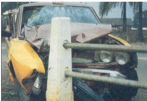
تصویر (۵-۴-۴) برخورد وسیله نقلیه با حفاظی که به شکلی نادرست نصب شده است.
