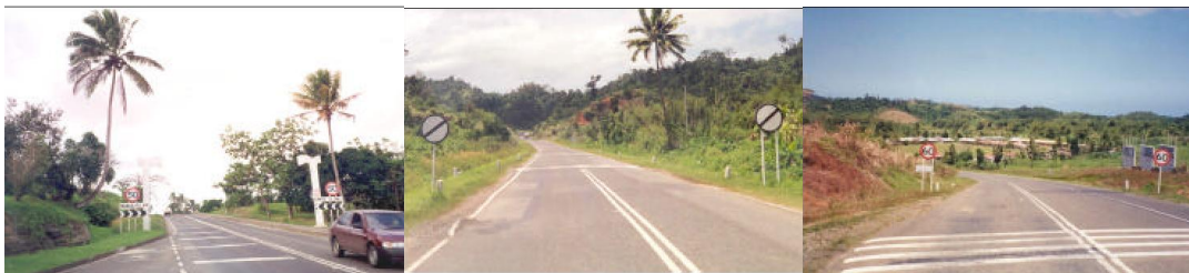
تصویر (۴-۵-۴) نوار لرزآور، فیجی تصویر (۴-۵-۴) سرعت‌گیر، فیجی تصویر (۴-۵-۴) دروازه ورودی، فیجی
