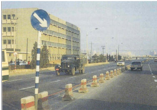
تصویر (۴-۴-۴) بلوک بتنی و نرده‌های فولادی متحرک در جمهوری خلق چین
