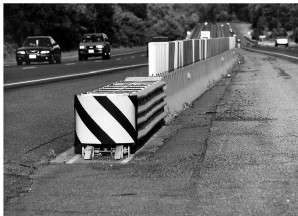
شکل پ ۳-۸- ضربه‌گیر کاهش‌دهنده تریبیتی
