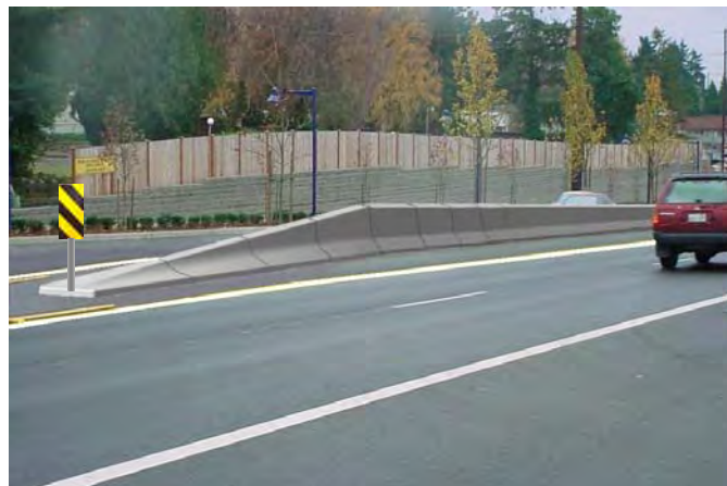
شکل ۲-۱۴- شیب‌دار کردن انتهای حفاظ بتنی
