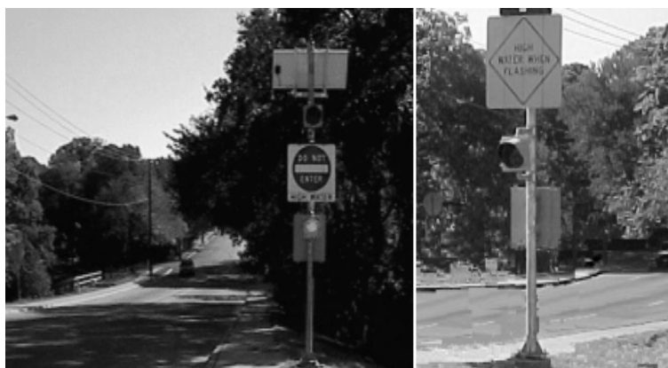
شکل (۲-۱۳) نمونه‌ای از تابلوهای پیام متغیر خبری برای اعلام وضعیت عادی (تصویر سمت راست) و برای وضعیت هشدار سیل (تصویر سمت چپ) (حبیبی نوخندان، ۱۳۸۴)
