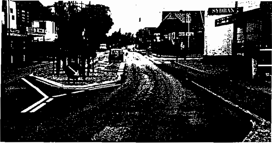
شکل ۲۹ نمونه باریکه کردن جاده و پیچاندن سواره‌رو.
