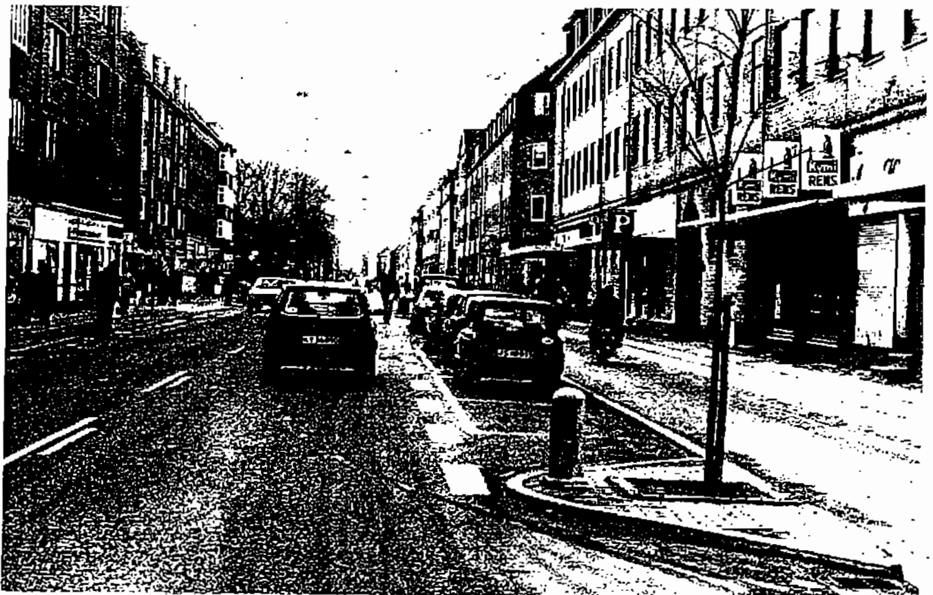
شکل ۱۳ پیش‌آمدگی برای جدا کردن خط پارکینگ از سواره‌رو در خیابانهای محلی.
