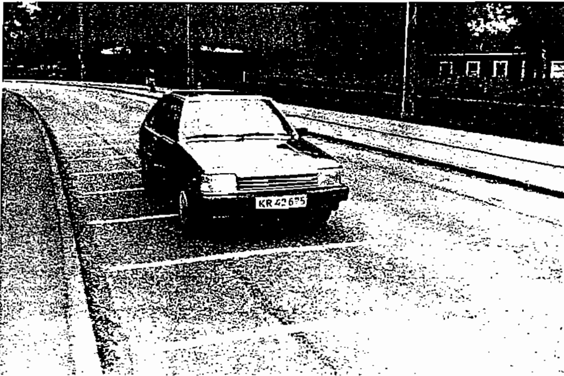
شکل ۴۶ استفاده از خط کشی برای کاهش سرعت
