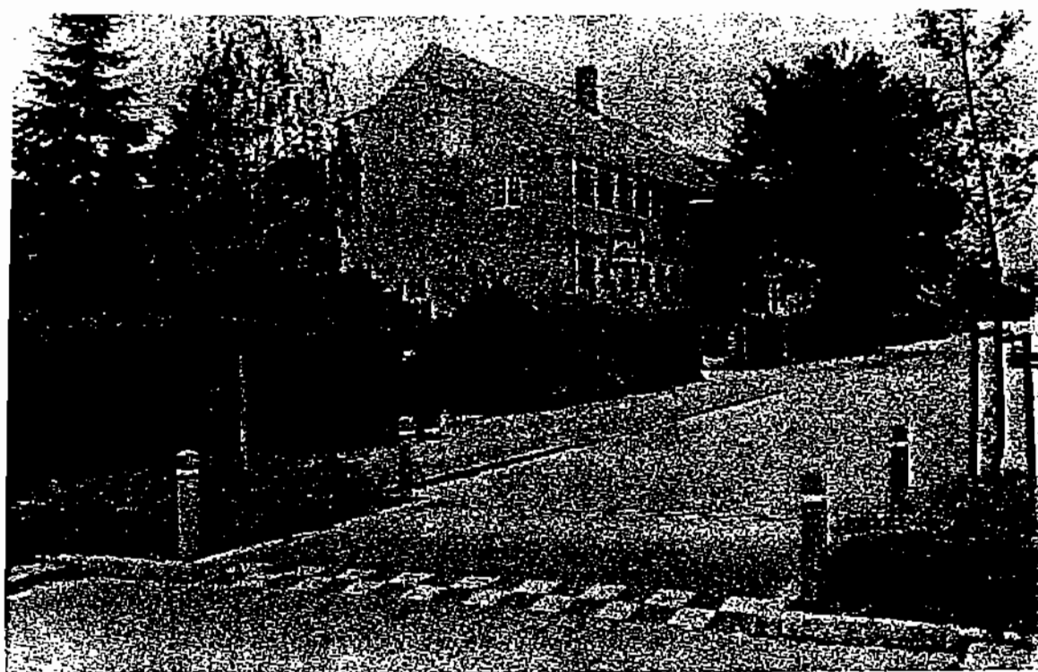
شکل ۳۱ یک خطه کردن سواره‌رو و گرده‌ماهی.
