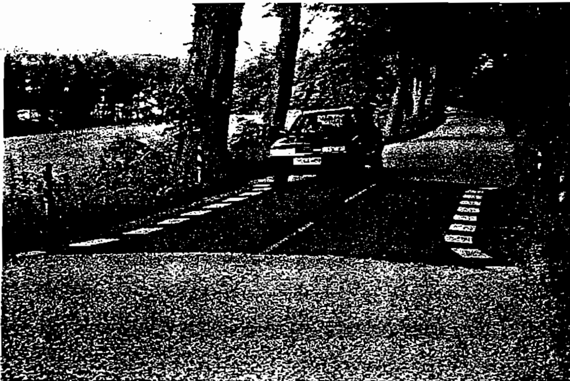
شکل ۳۸ باریک نمایاندن راه با خط کشی کنار و تفاوت رنگ روسازی.
