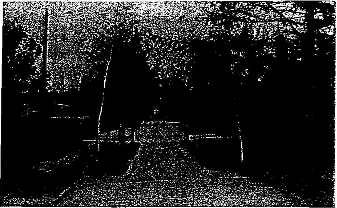
شکل ۳۵ باریک کردن سواره‌رو با باغچه کردن قسمتی از آن.
