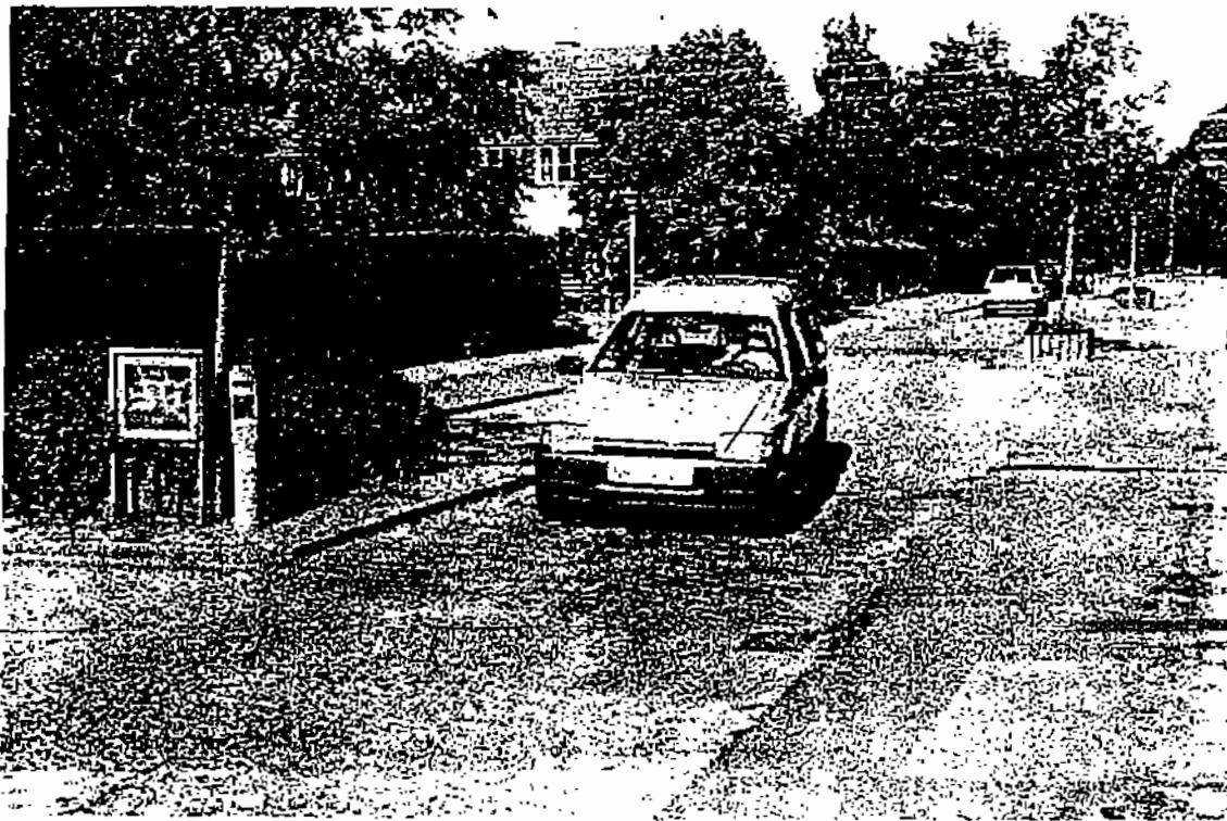
شکل ۳۷ ترکیب پیچاندن، باریک کردن، و متمایز ساختن جنس روسازی.
