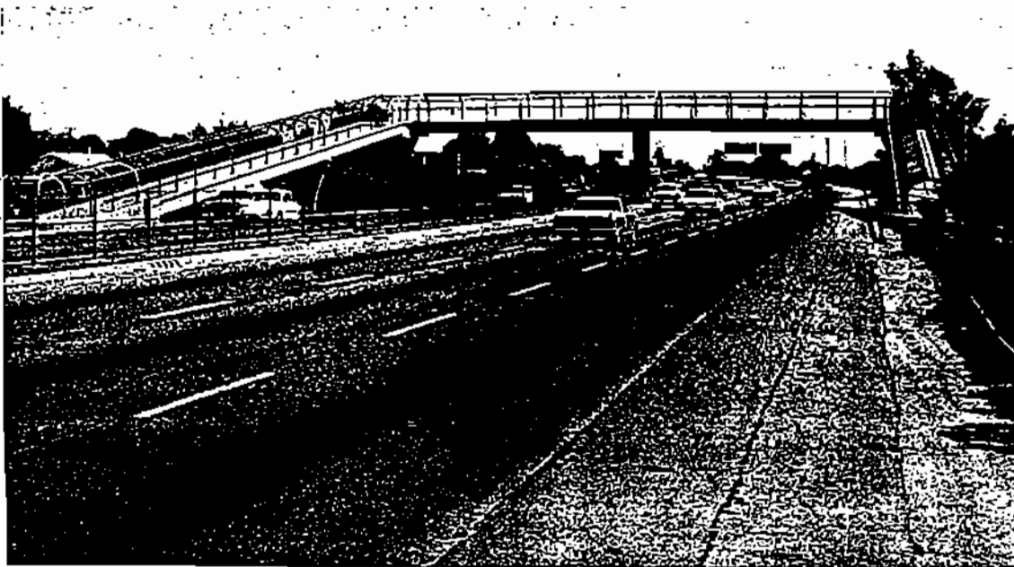
شکل ۲۵ نمونه روگذر مخصوص پیاده‌ها، نرده و توری به این منظور نصب شده که پیاده‌ها نتوانند از بالا چیزی به داخل سواره‌رو پرتاب کنند
