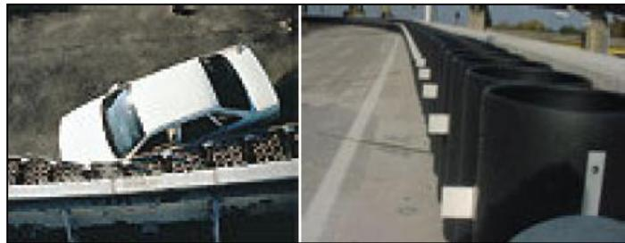
شکل (۲۰): نمونه‌ای از دیوارهای ضربه‌گیر لاستیکی
